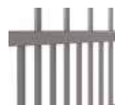
Espacement réduit par rajout de tubes dans le soubassement
