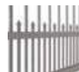
Espacement réduit par rajout de tubes débordants et pointes dans le soubassement
