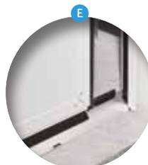
**E** Etanchéité renforcée tout autour de la porte avec le mixte de joint brosse et EPDM permettant d'obtenir la classe 3 de perméabilité
